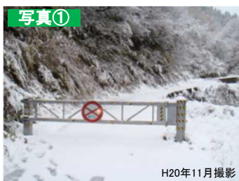
冬期通行止め状況(福井県側)
