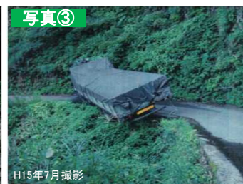
急カーブ箇所での大型車の脱輪
