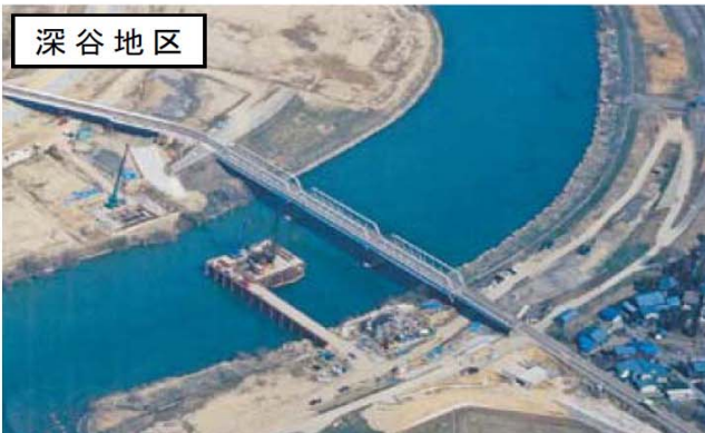
明治橋の施工状況
