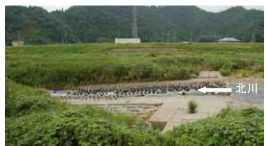
魚道を設置した孫城床固工
