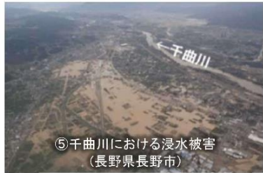
【令和元年東日本台風】
