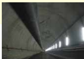
⑤コンクリートを打って仕上げます。
