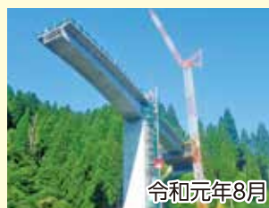
②道路部分となる橋桁は、「張出し架設工法」によって橋脚を中心に「やじろべえ」のようにバランスをとりながら延伸していきます。
