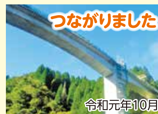
②道路部分となる橋桁は、「張出し架設工法」によって橋脚を中心に「やじろべえ」のようにバランスをとりながら延伸していきます。
