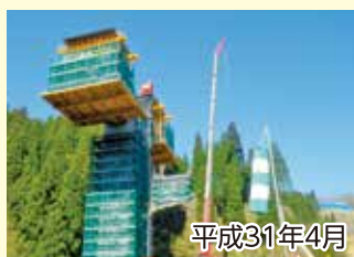
②道路部分となる橋桁は、「張出し架設工法」によって橋脚を中心に「やじろべえ」のようにバランスをとりながら延伸していきます。
