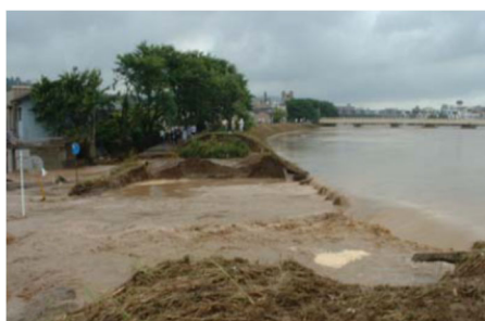
足羽川流域（福井市春日付近：堤防の決壊） 平成16年7月18日 出水
